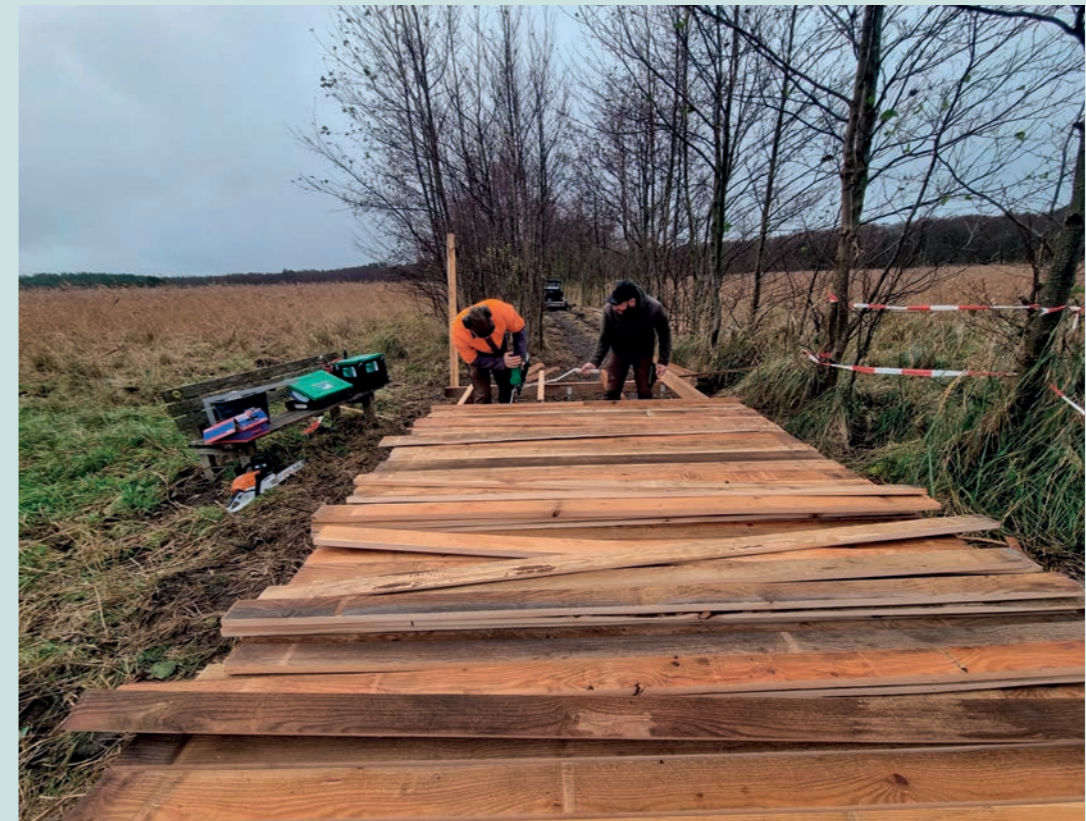
Martin Wolter (rechts) und Andreas Zahn (links) bringen die von einem mobilen Sägewerk geschnittenen Bohlen auf die richtige Länge. Foto: R. Linke
