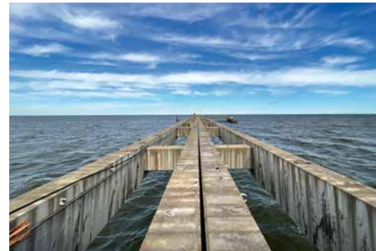
Vorbereitung der Seebrücke zum Rückbau der Tragkonstruktion.
