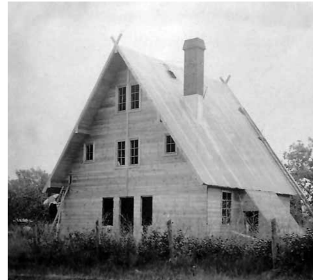
Rohbau des Wohnhauses 1925.
